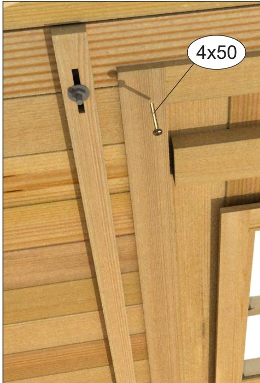
Sorgen Sie für eine gute Unterkeilung der Türen, bevor Sie sie fest anziehen. Die Seitenrahmen müssen mit 2 Schrauben unten auf der Halbbohle, 1 Schraube auf der 2. Bohle und oben mit einer Schraube auf dem oberen Rahmen befestigt werden. Verwenden Sie 4 x 50er - Schrauben.
