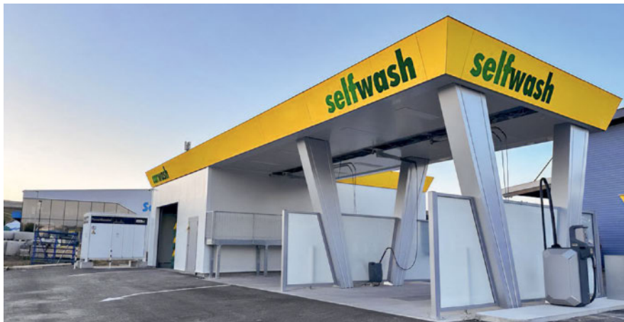
La LANDI de Jegenstorf a bénéficié d'un généreux agrandissement. Halle de stockage, station de lavage et borne de recharge rapide viennent compléter le magasin agrandi. Photo : Adrian Grossenbacher
