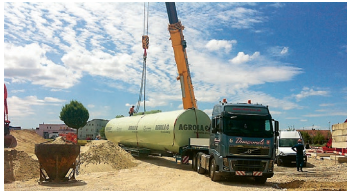
Der Agrola-Tank wurde in Payerne versenkt - ein grosser Schritt vorwärts im Neubau.
