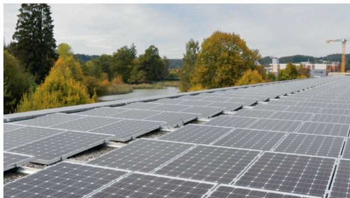
Die neue Photovoltaik-Anlage hat eine Modulfläche von 2072m 2 .
