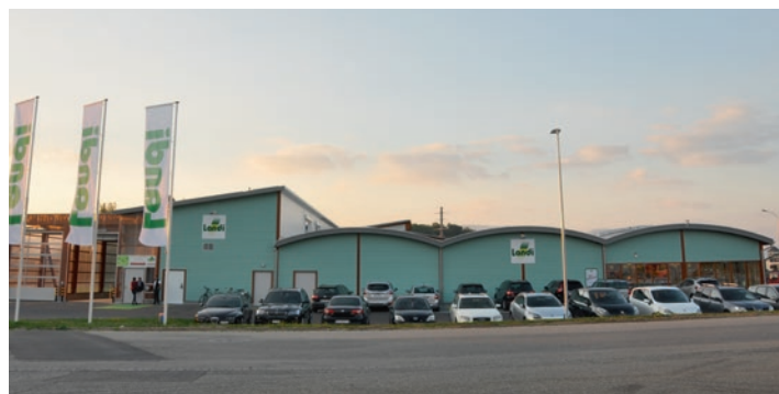
Der neue LANDI-Laden in Herzogenbuchsee, links der exklusive Anlieferungstunnel.
