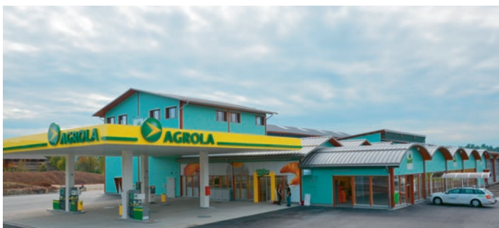
Mehr in die Höhe, weniger in die Breite: Dieses Prinzip wurde bei der Bauplanung berücksichtigt, um den Flächenverbrauch zu minimieren.
