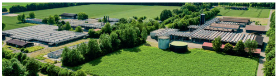
Der AgriCo-Campus verfügt über Büros und Labors, aber auch über 150 000 m 2 bebaubares Land in der Arbeitszone. Bild: zVg
