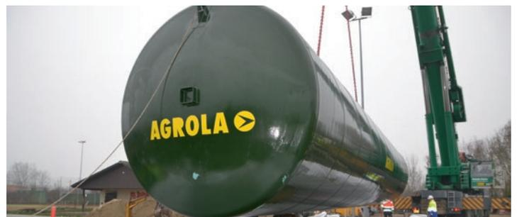
**Der Kraftstofftank wird vorsichtig in die Grube versenkt.**
