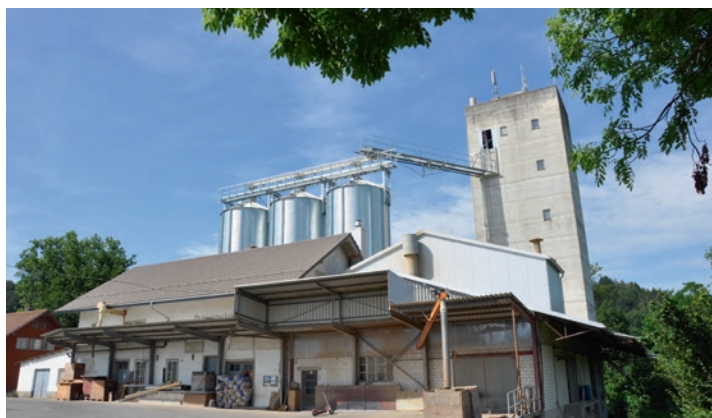
Doppelte Kapazität: Neue Blechsilos in Oberkulm.
