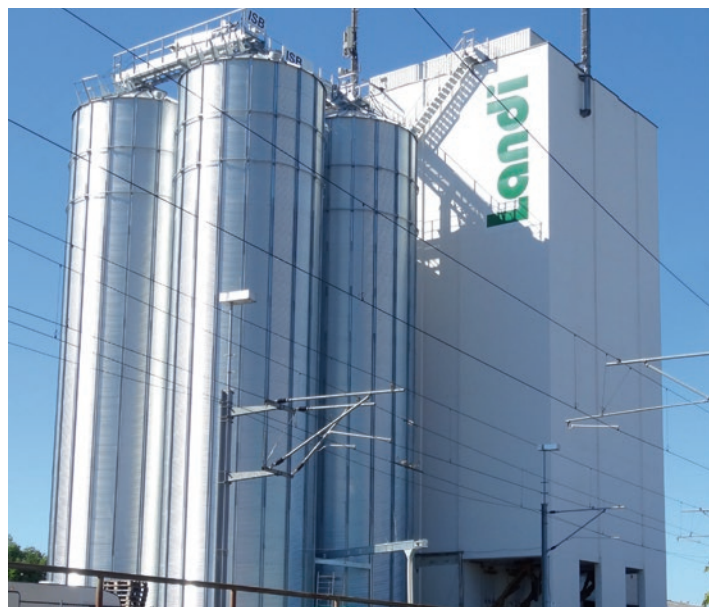
Das erweiterte Silo hat nun eine Kapazität von über 6000 Tonnen.
