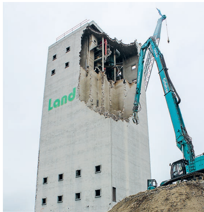
Das 46-jährige Silo wurde abgerissen.
