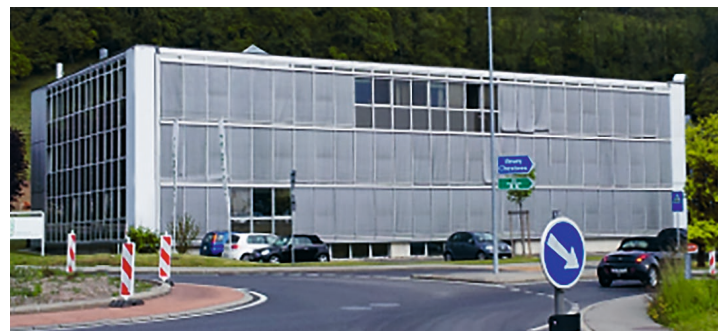
Das Gebäude in Puidoux wies Renovationsbedarf auf.
