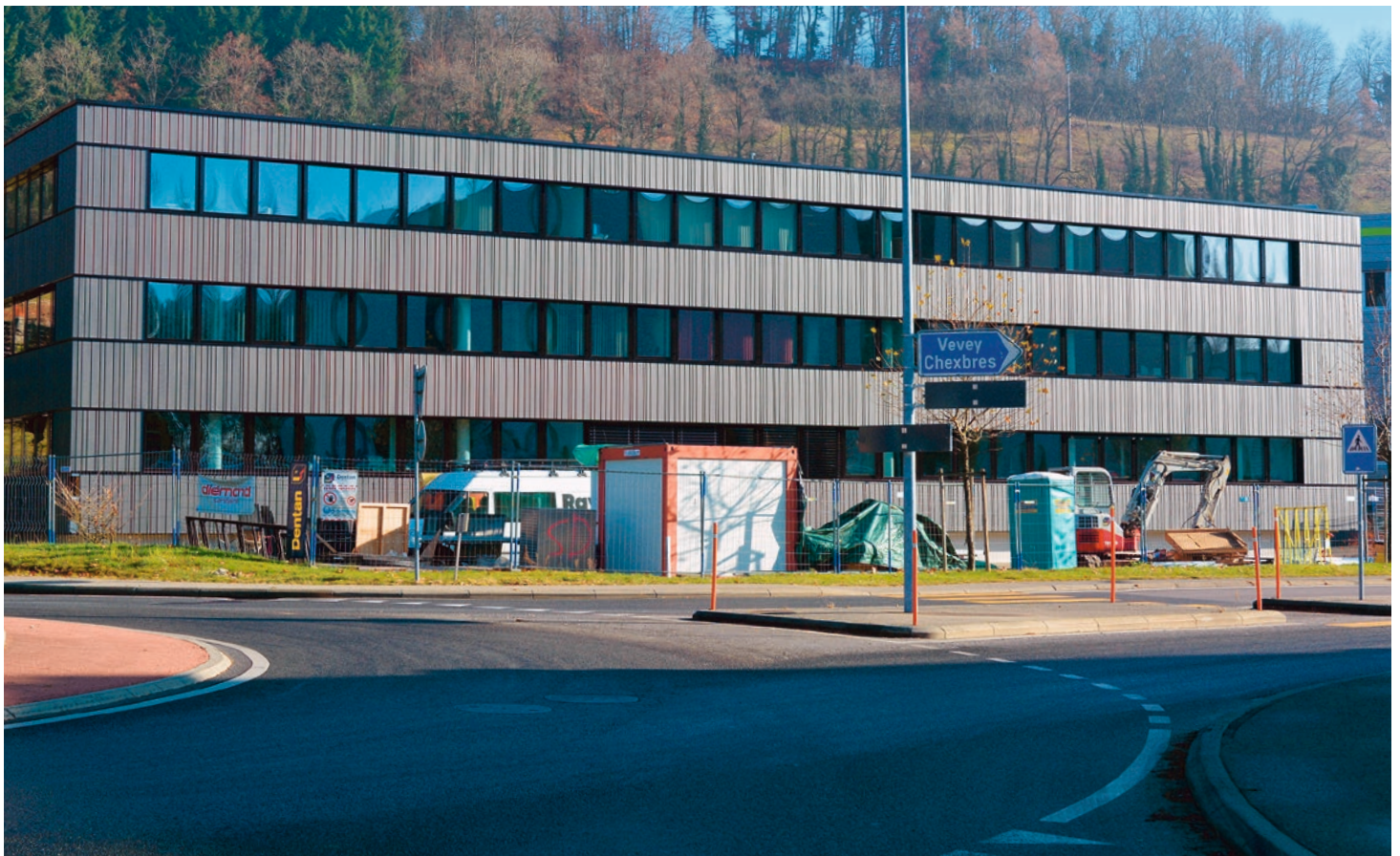
Das renovierte Gebäude des fenaco-Sitzes in der Westschweiz.
