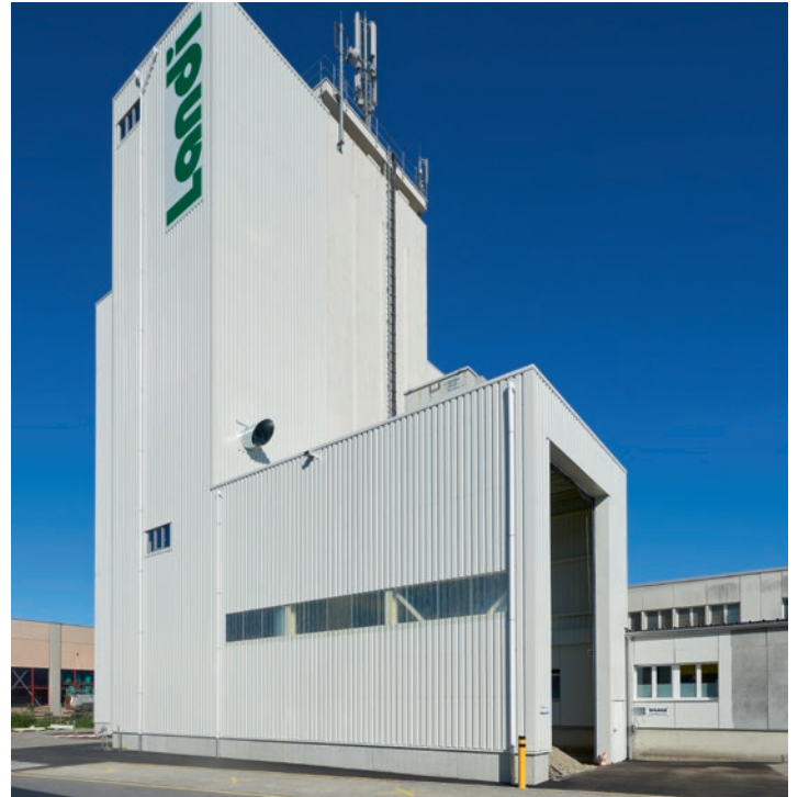
Die erweiterte Siloanlage in Tifers.
