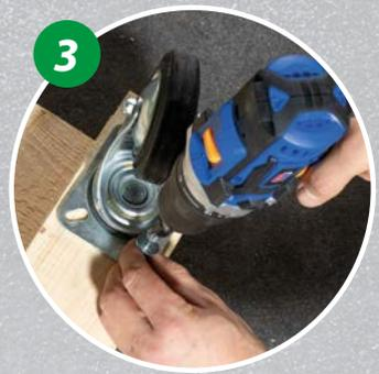
3 Nehmen Sie den Akkuschauber und 16 Spanplattenschrauben kurz zur Hand.
